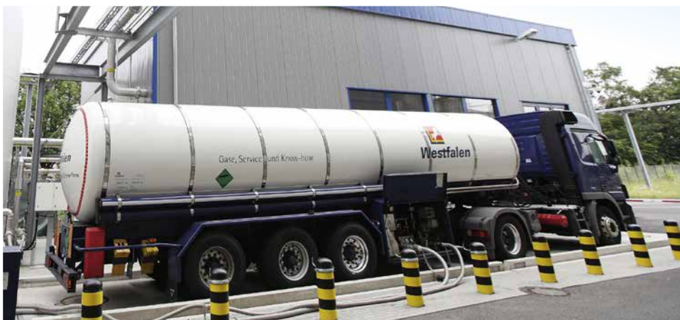
Auch die Kohlendioxid-Produktionsanlage Lüdinghausen wurde 2019 wieder für ihr Umwelt- und Energiemanagement zertifiziert.
