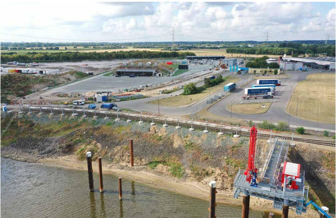
Das Flüssiggas-Tanklager im Sommer 2020 mitten in den Bauarbeiten (im Uhrzeigersinn von vorne rechts): Schiffsanleger, Pumpenstand, Technikgebäude, Flaschen-Abfüllung und Bürogebäude.
