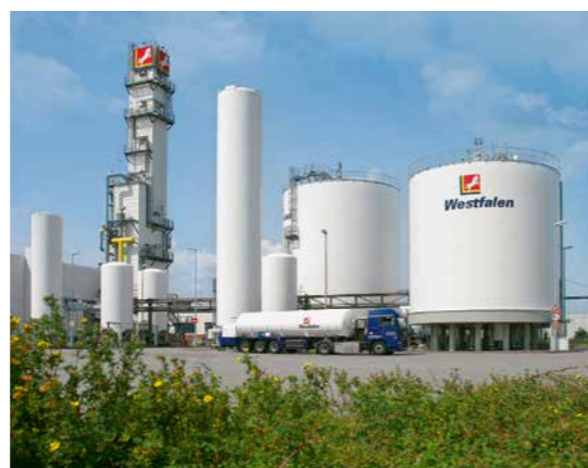
Die Luftzerlegungsanlage in Hörstel, rund 50 Kilometer nördlich von Münster, wurde 1993 errichtet. Weitere Luftzerlegungsanlagen betreibt die Westfalen Gruppe in Laichingen bei Ulm sowie im französischen Le Creusot.
