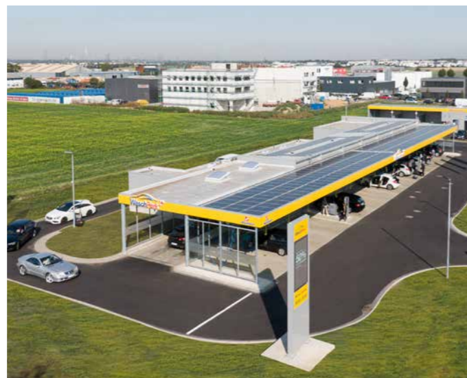
Der Westfalen Waschpark in Köln-Lövenich wäscht bereits seit 2021 CO 2 -neutral; seit dem 1. Januar 2023 ist das an weiteren fünf Standorten der Westfalen Gruppe möglich.
