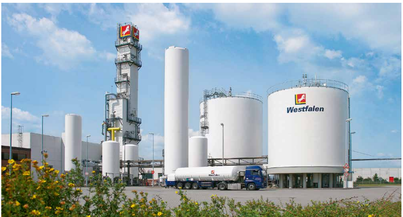
Moderne Luftzerlegungsanlage in Hörstel, Kreis Steinfurt.
