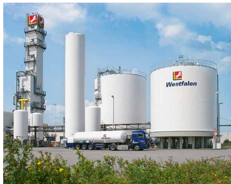
Die Luftzerlegungsanlage im Werk Hörstel bei Osnabrück.
